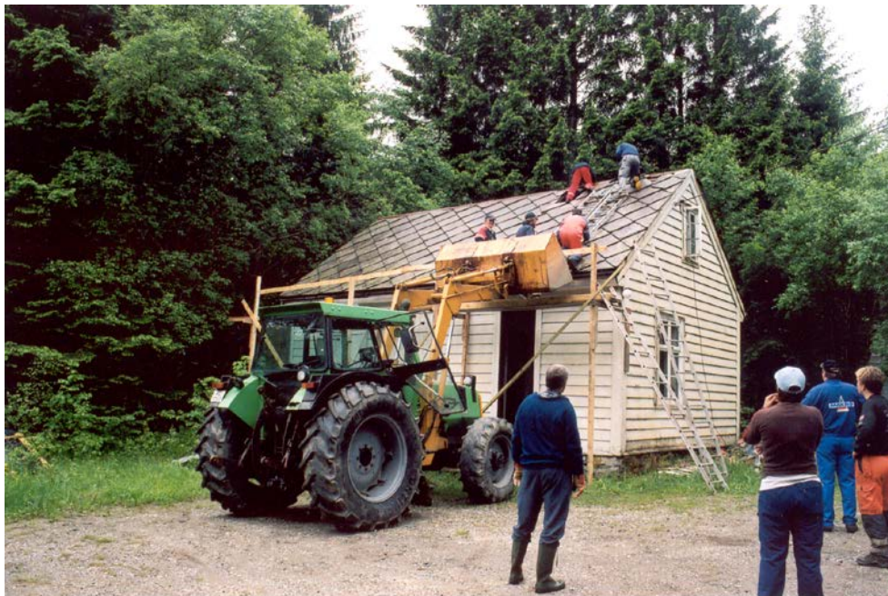
Bilde 2 Dugnadsgjengen i full gong med å ta av hellene frå taket
