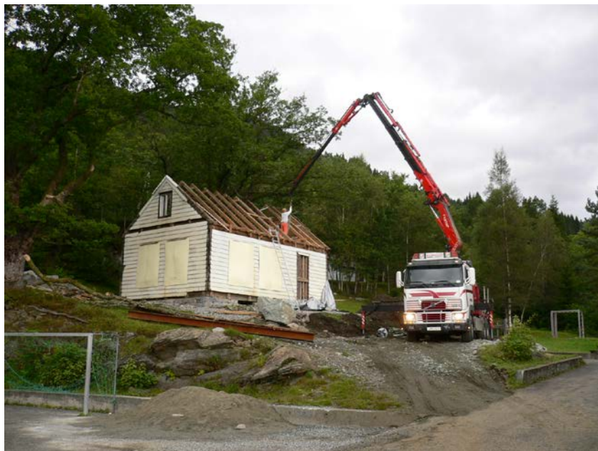
Bilde 7 Sperrene vart heist på plass
