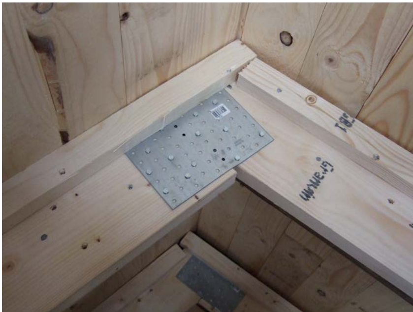
Bilde 9 Eksisterande sperrer vart forsterka og retta av før isolering og paneling
