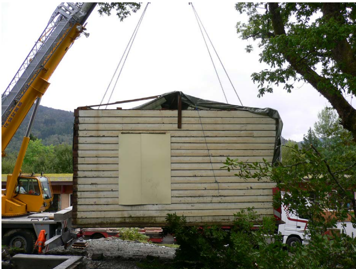
Bilde 6 Huset på veg inn på den nye grunnmuren
