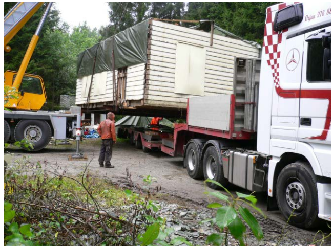
Bilde 4 Huset på veg opp på lastebilen
