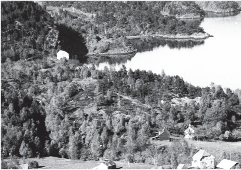
Foto frå 1962, då veganlegget Rolvsvåg-Heiane starta. Til høgre i biletet ser me at sprenging og utfylling er i gang.
